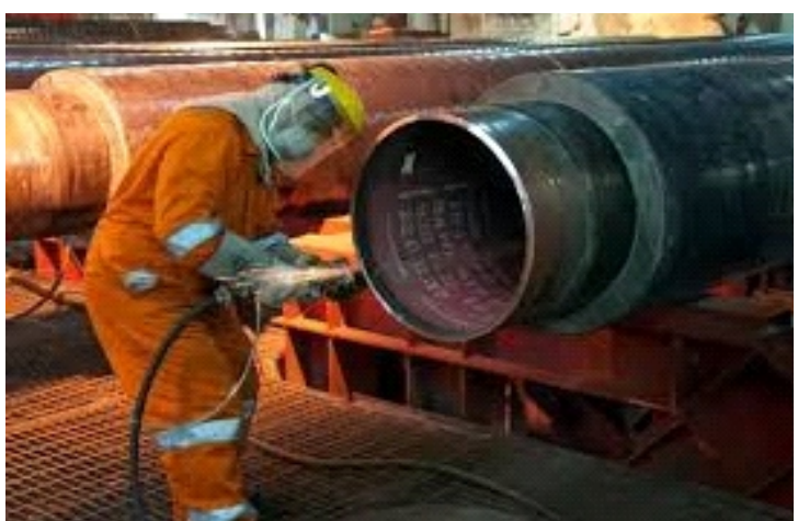
Завод по ремонту и восстановлению труб •ООО «ЧЗВТ»
